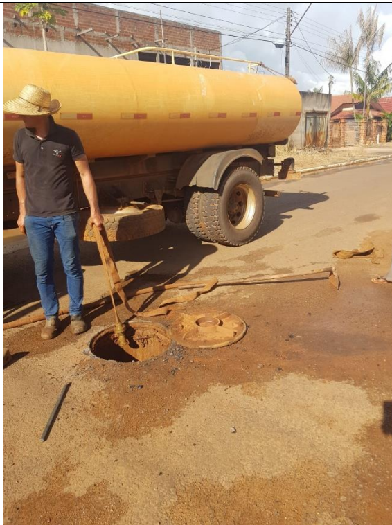
Figura 03: PV-09 não obstruído e apresentando fluidez Fonte: Mamoré/2022.
