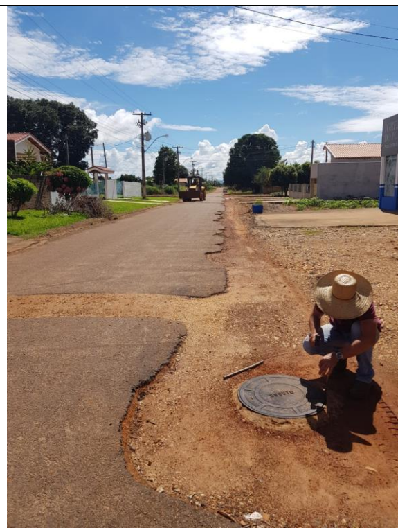
Figura 04: Tubulação para interligação domiciliar Fonte: Mamoré/2022.
