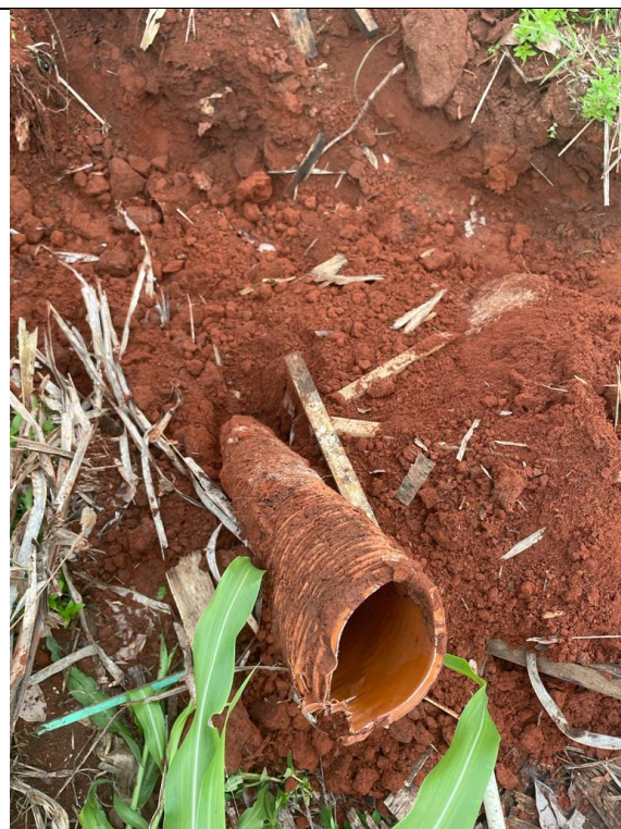
Figura 05: Tubulação para interligação domiciliar Fonte: Mamoré/2022.
