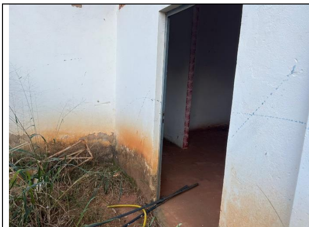
FIGURA 10 – Galpão de Eventos – Fonte: Mamoré 2023.
