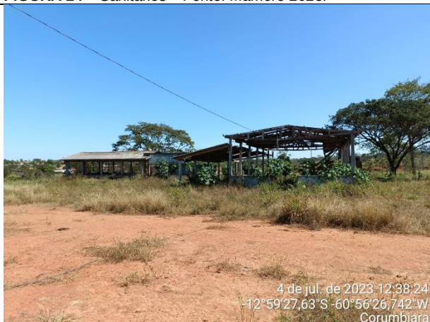
FIGURA 26 – Galpão de eventos – Fonte: Mamoré 2023.
