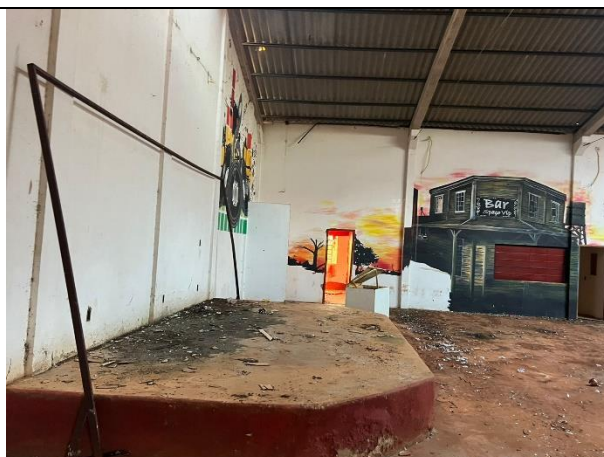
FIGURA 11 – Galpão de eventos – Fonte: Mamoré 2023.
