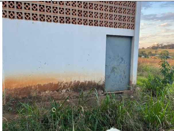
FIGURA 09 – Galpão de Eventos – Fonte: Mamoré 2023.
