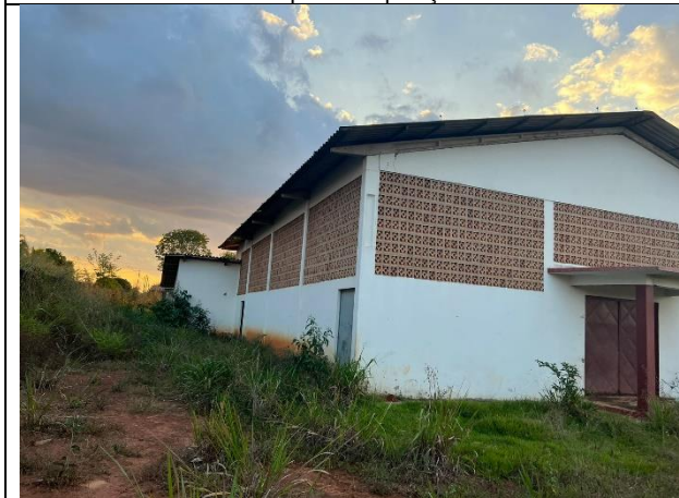
FIGURA 08 – Galpão de Eventos – Fonte: Mamoré 2023.
