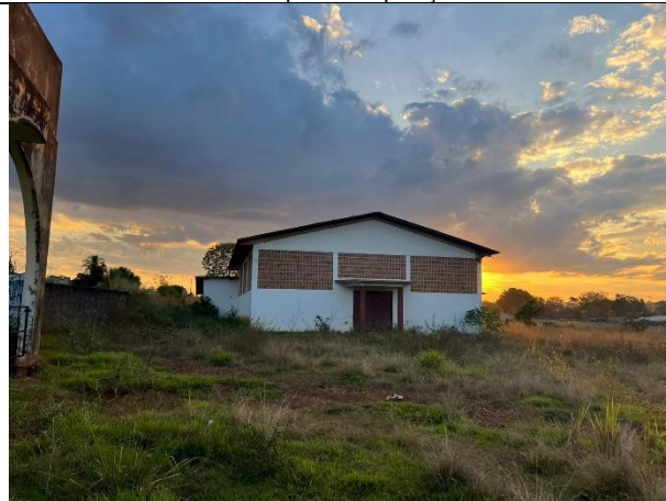
FIGURA 07 – Galpão de Eventos – Fonte: Mamoré 2023.
