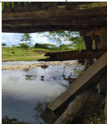
Área da ponte
