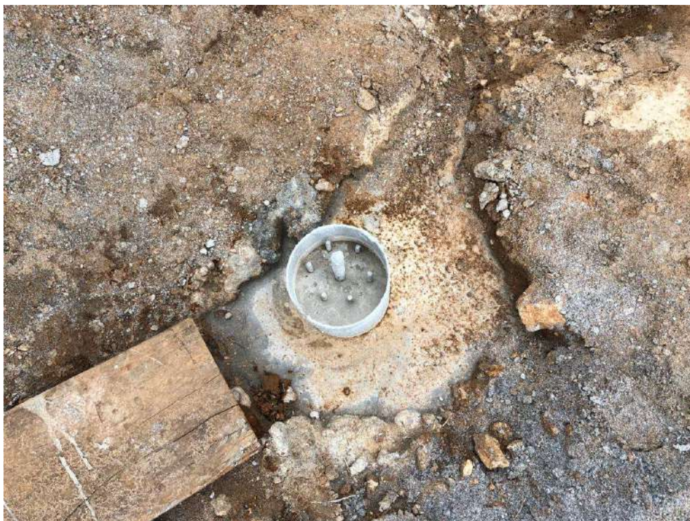
Imagens de execução da Micro-estaca-Raiz
