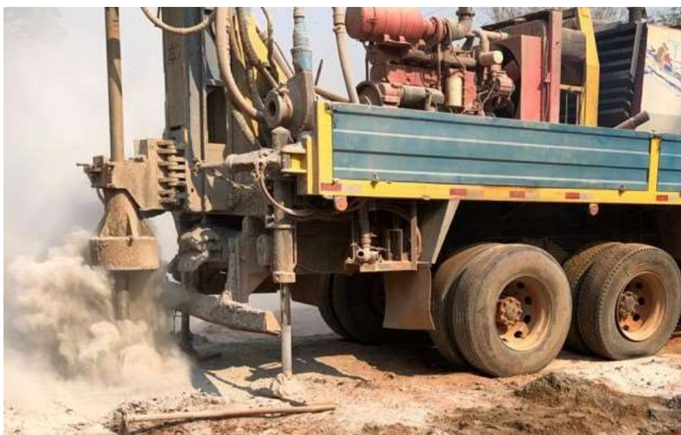
Imagens de execução da Micro-estaca-Raiz
