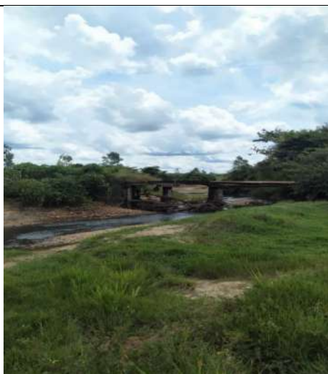
Visão da Ponte
