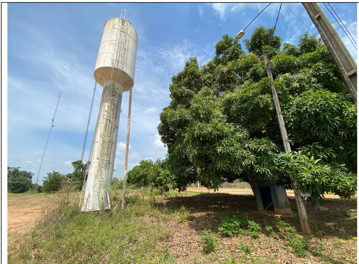
Foto 03 – PONTO DE INTERLIGAÇÃO DA REDE (ATUAL RESERVATÓRIO DE ABASTECIMENTO DO DISTRITO)
